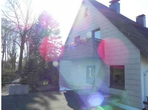
Blick vom Garagendach
